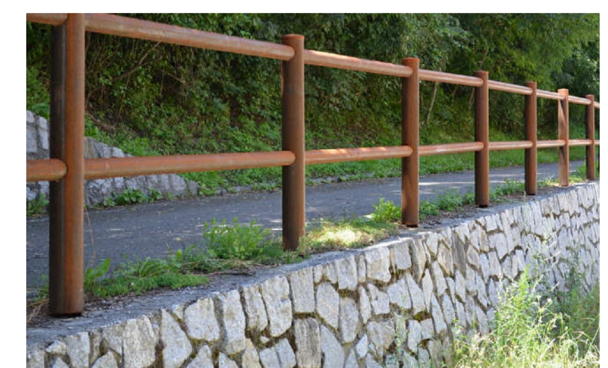
TIPOLOGIA PARAPETTO/STACCIONATA IN CORTEN
